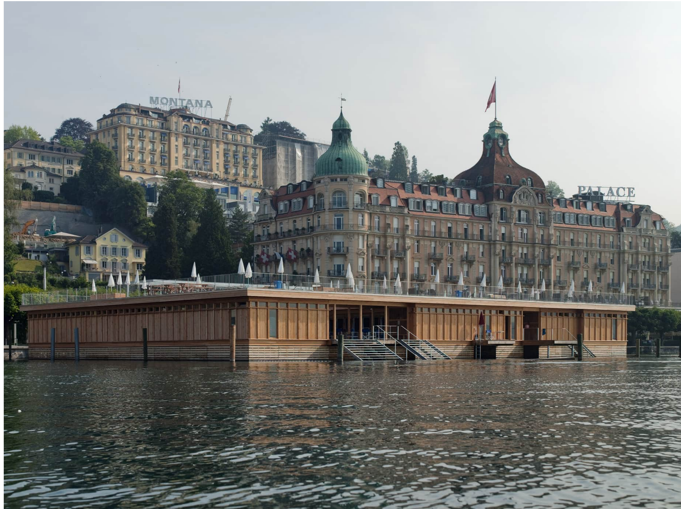
Erneuerung Seebad Nationalquai, Luzern, Bosshard & Luchsinger Architekten AG, 2010
