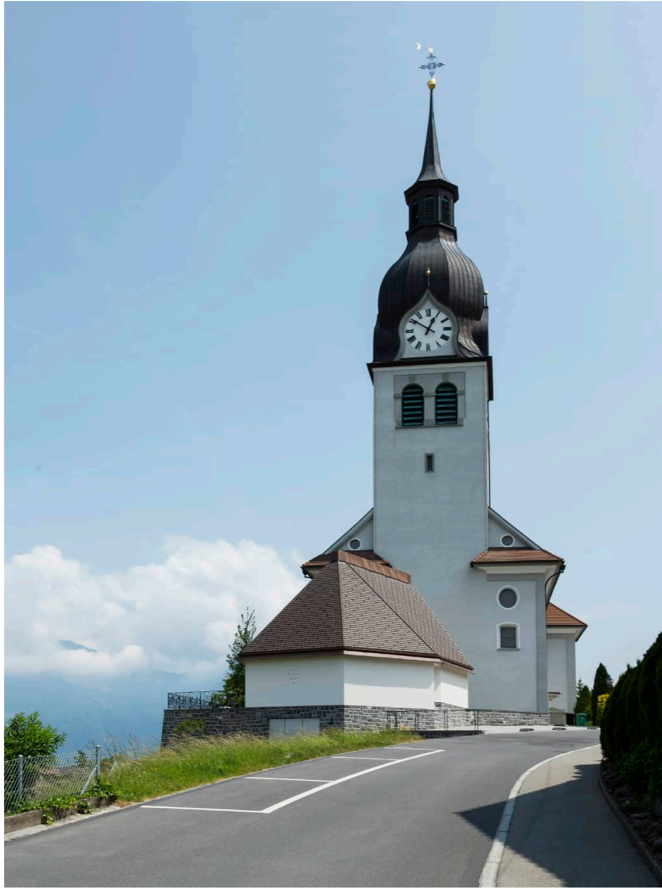
Neubau Totenkapelle, Buochs, Seiler Linhart Architekten, 2017
