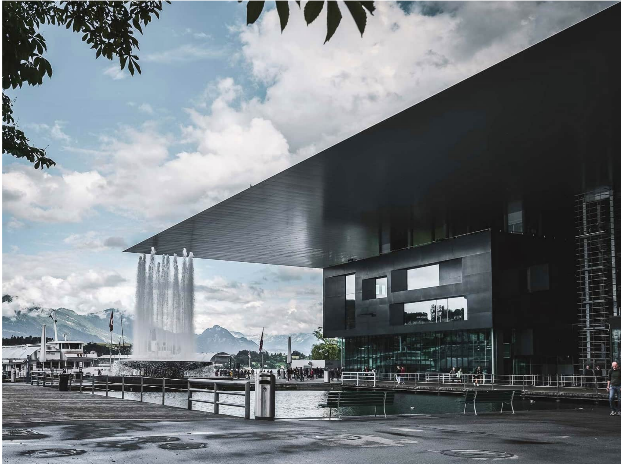
Neubau KKL, Kultur- und Kongresszentrum Luzern, Jean Nouvel, 1998
