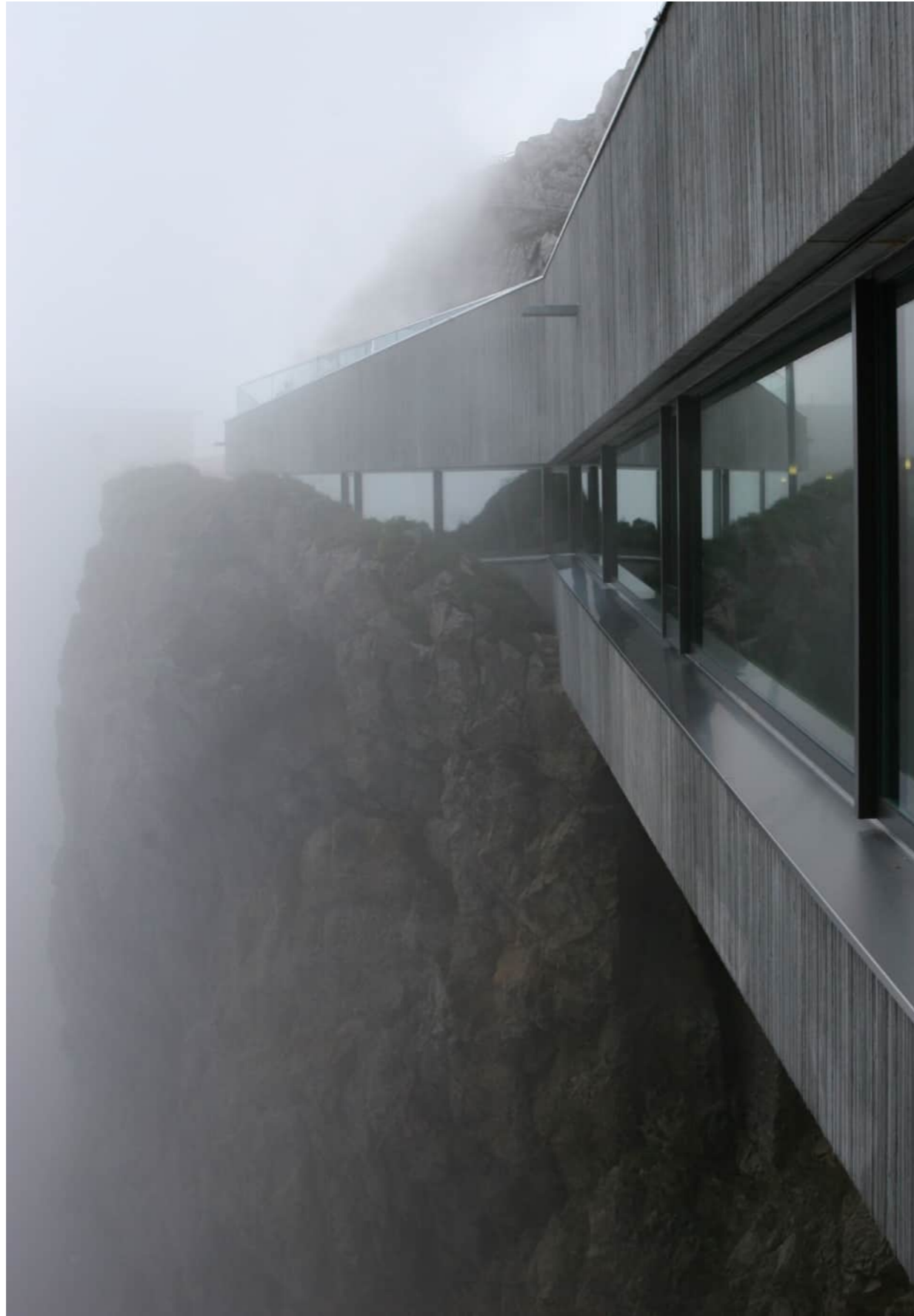
Neubau Panoramagalerie, Pilatus Kulm Niklaus Graber & Christoph Steiger, 2011
