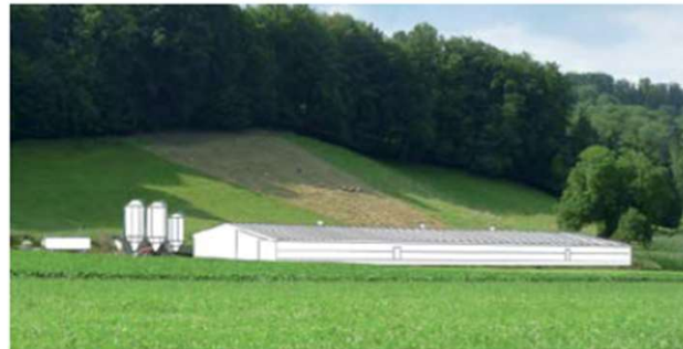
Die Lage am Hangfuss lässt den Bau optisch kleiner wirken.
