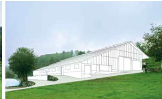
Die abgetreppte Einbettung des Baukörpers in die bestehende Hanglage verringert den Einsatz von Stützmauern.
