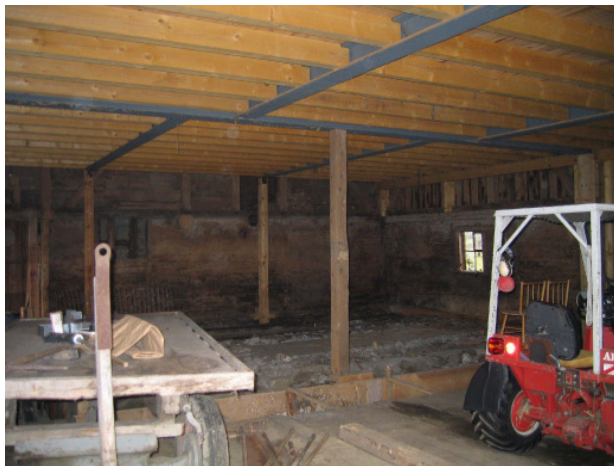
Abbildung 2: Beispiel von baulichen Massnahmen für die Hobbytierhaltung (Entfernung des Stallinnenraums, neues Fundament, neue und erhöhte Decken, Einbau von Fenstern und Türen zur Belichtung)
