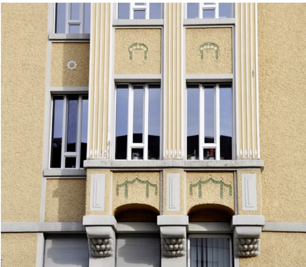
Überlegter Eingriff: Mit einem auf den Kopf gestellten Kämpferfenster entspricht die Jugendstil-Brüstung dieser Augenarztpraxis heutigen Normen.
