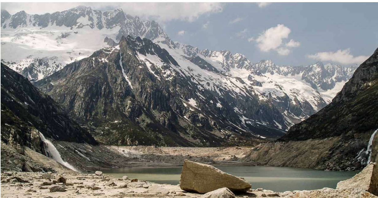
Le lac artificiel de Göschenalp est notamment alimenté par le Voralpreuss, rivière que le canton d'Uri a placée sous protection par le biais d'un règlement. Au bénéfice d'une concession depuis 1944, la centrale de Göschenen AG peut continuer d'utiliser l'eau du Voralpreuss. Aucune autre centrale ne peut être construite. Photo: B. Jud, VLP-ASPAN
