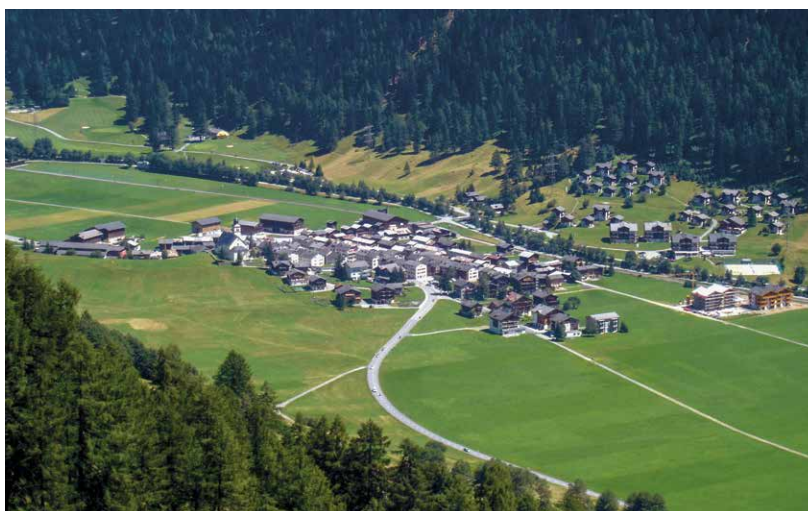
... et là, des dizaines d'années plus tard. La population locale a déménagé dans les nouveaux logements, à la périphérie du village. Les habitations créées selon l'ancien droit ne répondent plus aux besoins actuels et servent davantage de résidences secondaires.
