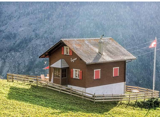
Les bâtiments d'habitation existants sis hors zone à bâtir, comme ici à Gspon VS, bénéficient d'une garantie étendue de la situation acquise. Photo: R. Muggli, EspaceSuisse
