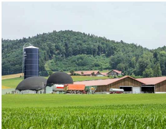
Les installations de biogaz, comme ici à Ittigen BE, sont, à certaines conditions, réputées conformes à l'affectation de la zone agricole. Photo: M. Ramseyer, EspaceSuisse
