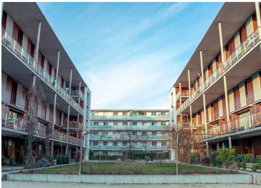
Dans les nouveaux immeubles des Ouches à Genève, les habitants se partagent divers locaux collectifs, dont une salle de musique.
